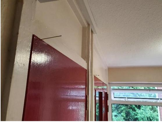
14. 2<sup>nd</sup> floor stair door – 9mm gaps, 10mm overhang
