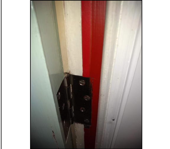
9. Flat door hinge & intumescent seal.
