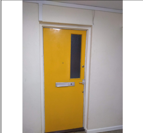
15. Flat 6 door & cables.
