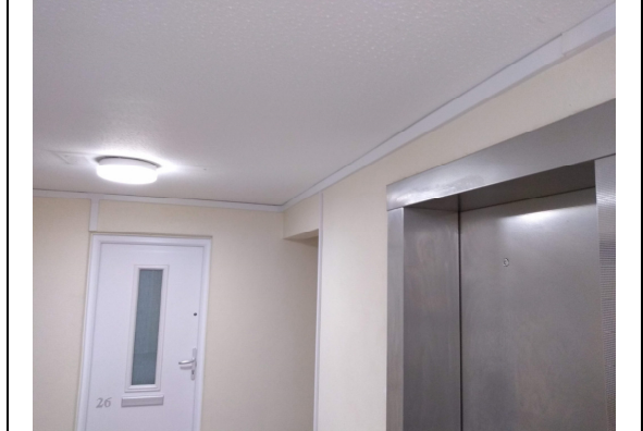
14. Conduit for telecoms/ TV cables.
